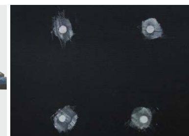
取付完了の裏面
